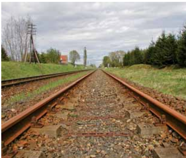
Rys. 9. Linia Szczecinek – Runowo Pomorskie – z dwóch torów szlakowych jeden jest nieczynny. FOT. M. WOŁEK
